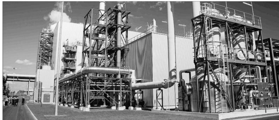
In Schwarze Pumpe betreibt der Energiekonzern Vattenfall eine Pilotanlage für ein CO 2 -freies Kraftwerk. Freiberger Wissenschaftler wollen Kraftwerke, die Chemiebetriebe mit Stromerzeugung sind. – FOTO: VATTENFALL
